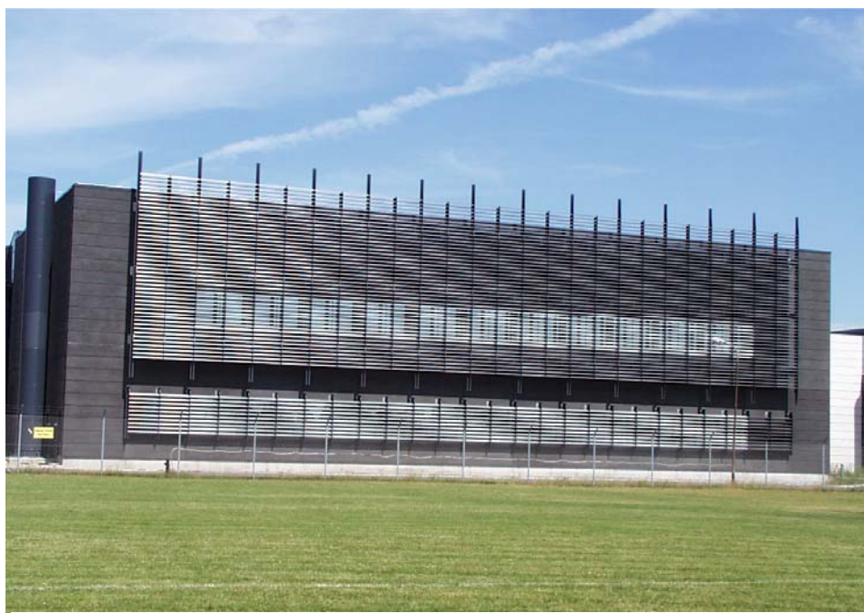
Den nye kontrolcentral, der blev taget i brug i slutningen af december 2007. (Foto: NAVIAIR).
