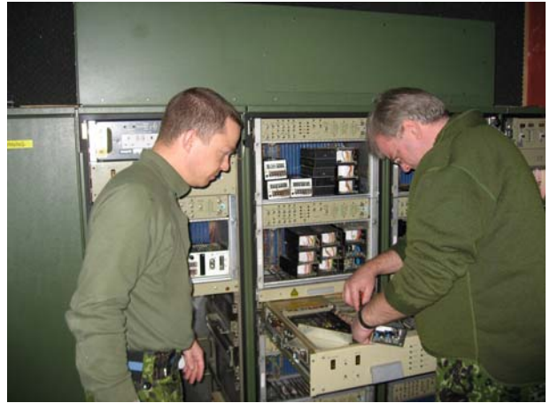
Demontering af EQ rum. Fra venstre ses radartekniker Carsten Wilms og elkraftmekaniker Michael Meyer Christensen.
