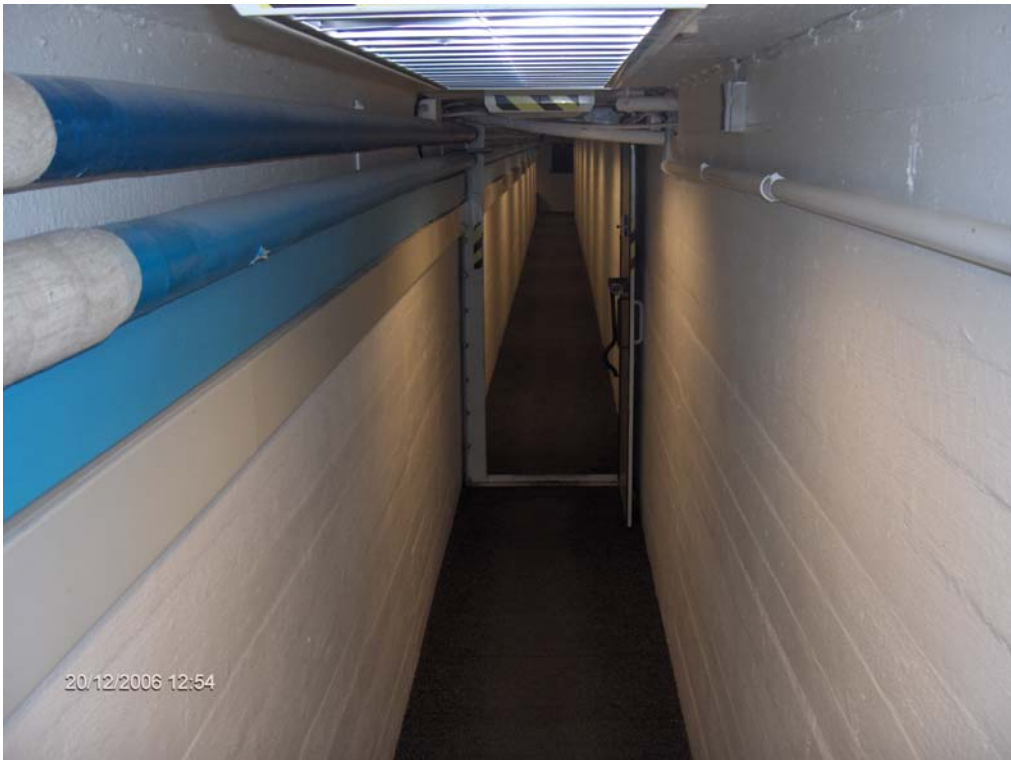
Den lange smalle adgangsvej til bunkeren i Vedbæk (Foto: FHS).
